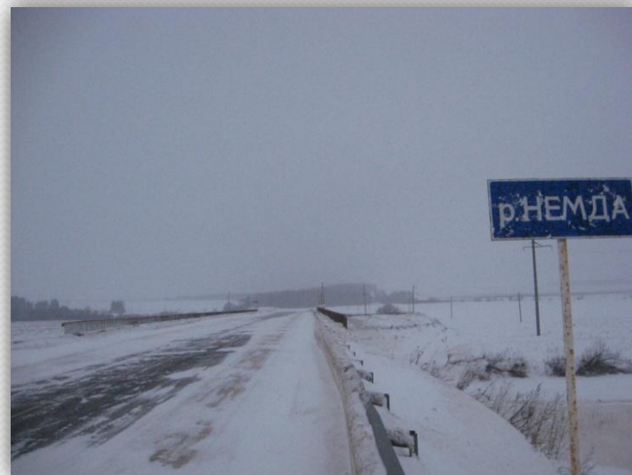
Новый типовой мост, 2012 г.
